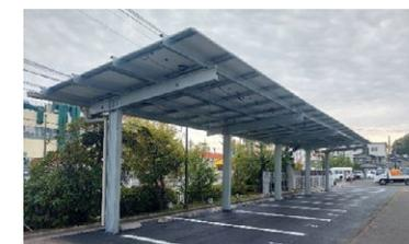
佐江戸車両試験場カーポートタイプ太陽光発電システム
