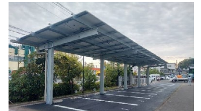
佐江戸車両試験場カーポートタイプ太陽光発電システム
